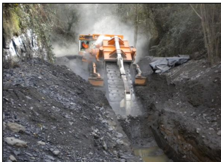
Instalación de conducción de FD 800 en vía verde.
