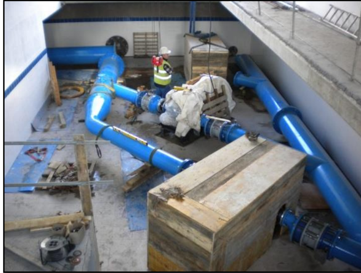
Apertura de zanja mediante zanjadora
