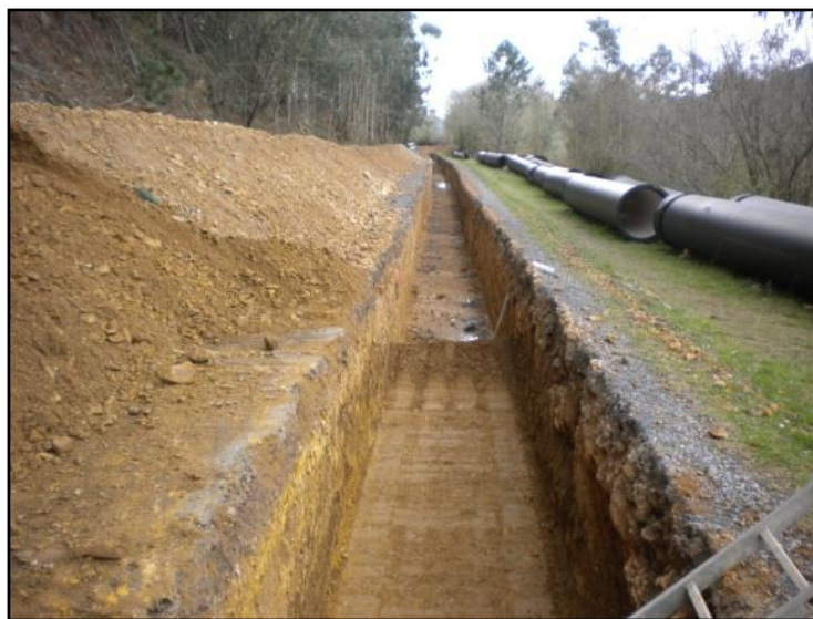
Instalación de conducción de FD 800 en vía verde.
