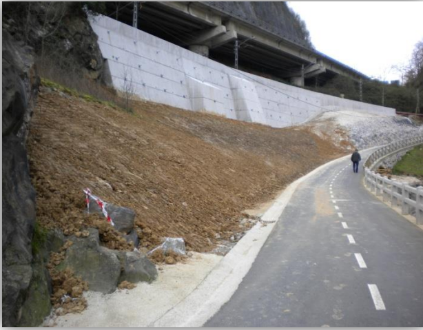
Sostenimiento de taludes de desmonte y refuerzo de muros existentes.
