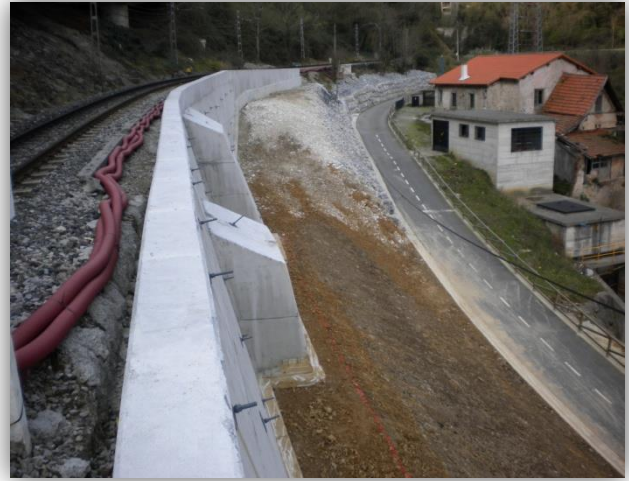
Sostenimiento de taludes de desmonte y refuerzo de muros existentes.
