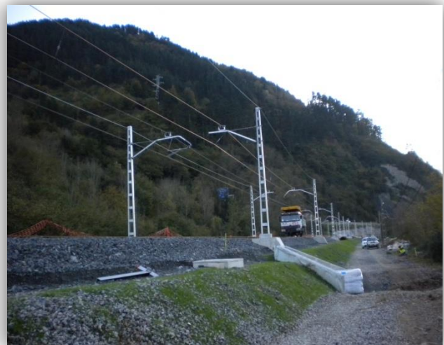
Nueva plataforma de vía, superestructura de vía y electrificación ferroviaria.
